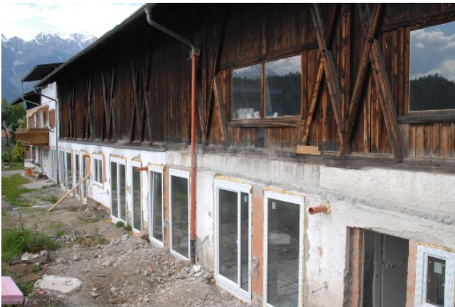
Der Umbau des Fritzenhofs im Jahre 2013.
