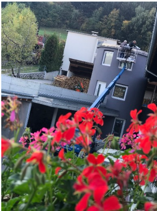
Der Wohn- bzw. Kreativturm ist außen fertig.
